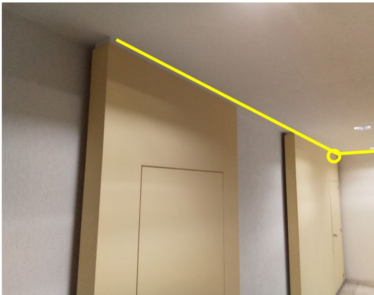
Boren naar gang met 3lu's op gv Door naar blok D
