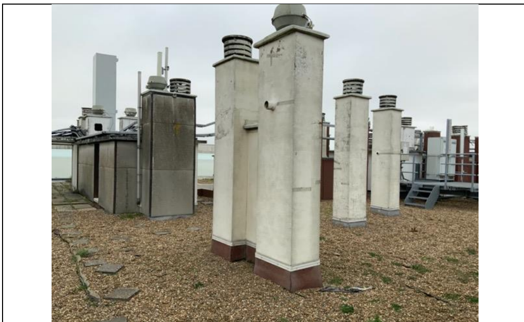
Foto 26 : dak van de residentie
