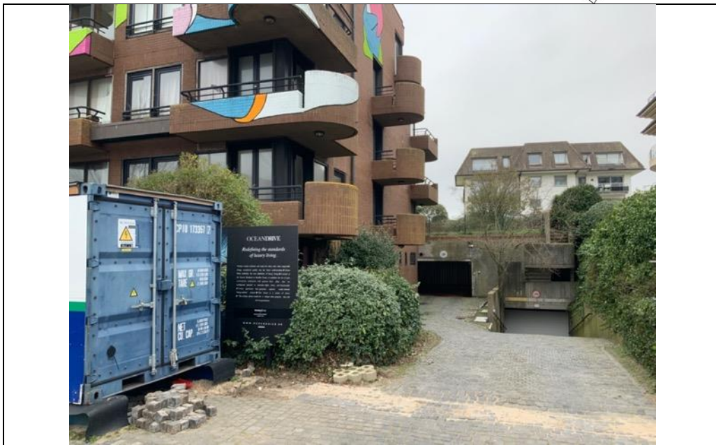
Foto 19 : ingang tot ondergrondse parking -1 en -2
