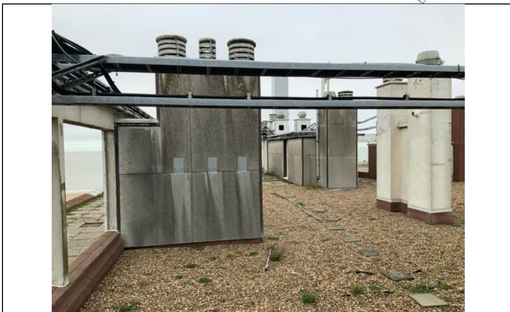
Foto 25 : dak van de residentie
