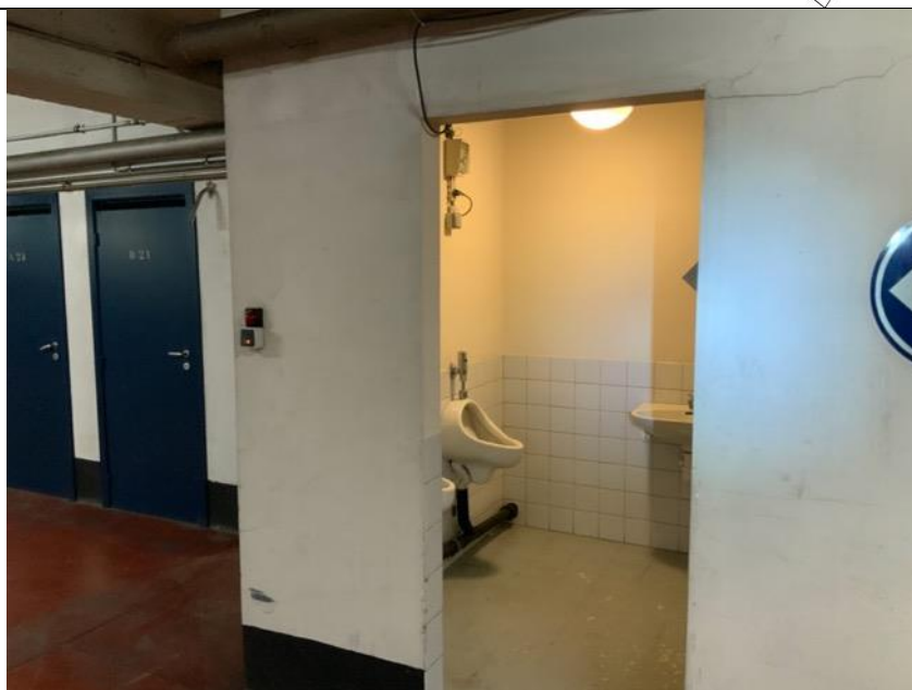
Foto 17 : toiletten in ondergrondse parking op -1
