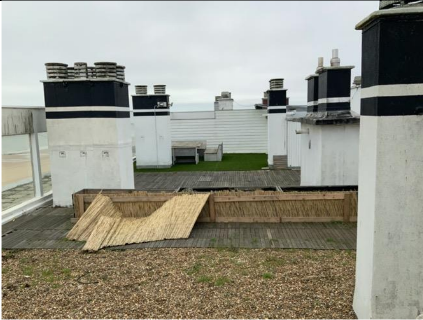
Foto 27 : dak van de residentie
